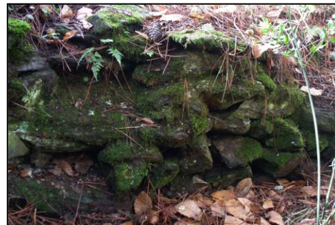
Foto 2. Estrutura exterior ao esporão a SE
