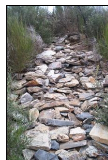
Foto 2. Derrube a NE.
