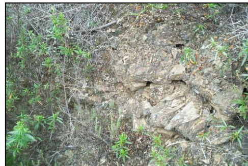
Foto 2. Pormenor do talude a Sul.
