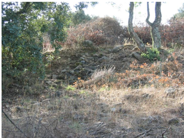
Fig.1 – Aspecto de derrube de muralha a Este.
