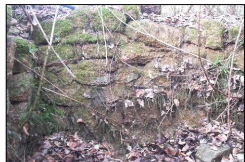
Foto 2. Vista SE do interior do forno.
