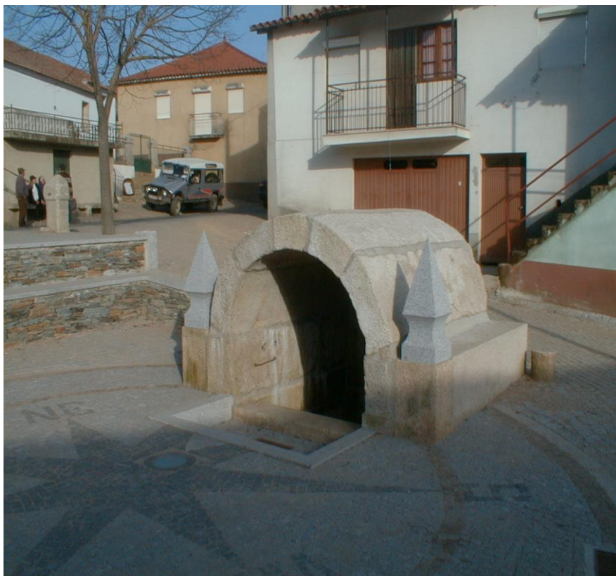
(Fonte de mergulho após restauro em 2003)
