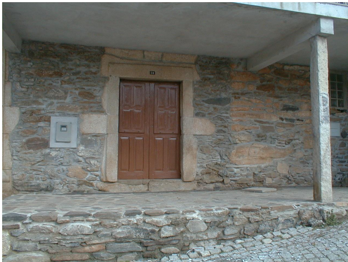
(Edifício do antigo Registo Civil)
