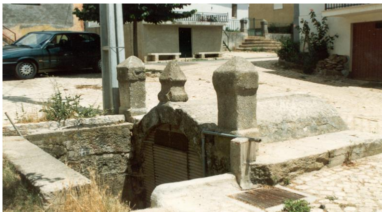
(Fonte de mergulho – Carrapatos (demolida e reedificada em 2003))
