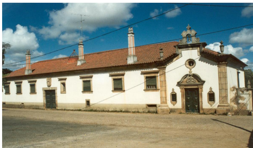
(Solar Conde de Almendra com capela anexa – Castelhães)
