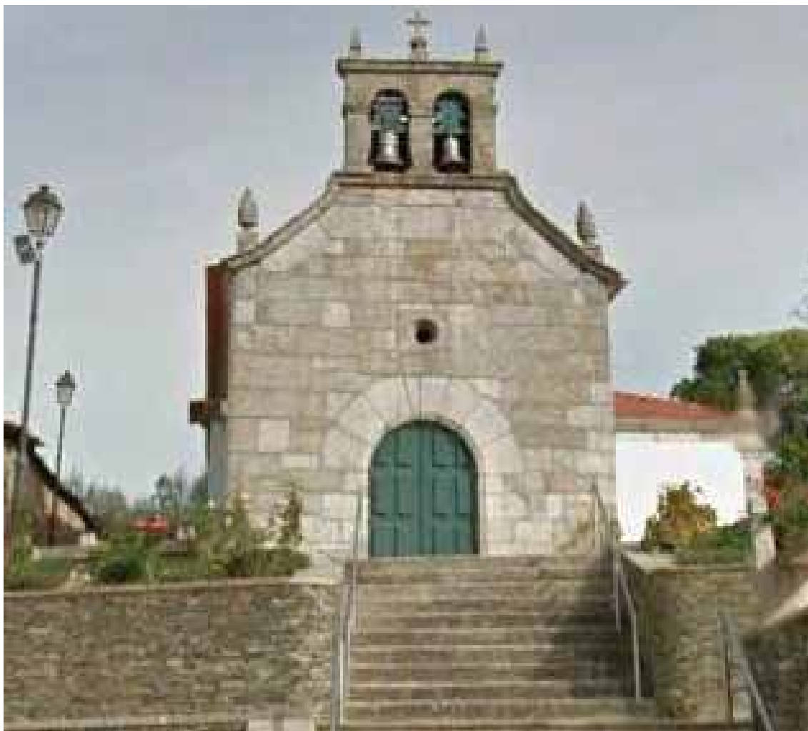
Igreja de S. Martinho de Tours de Vilar do Monte 37
