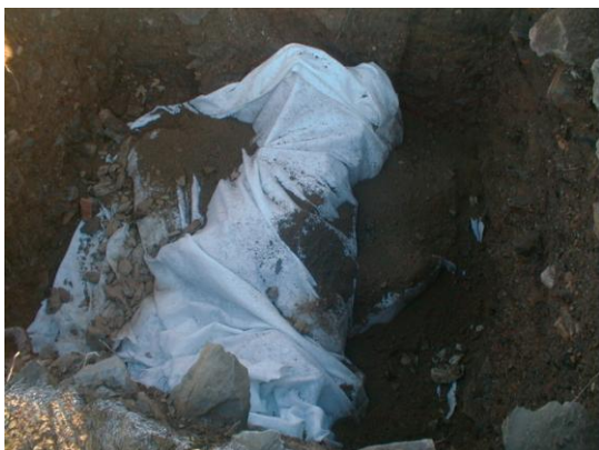
Foto 9 Aspecto da protecção com geotêxtil do sector “D” do Bovinho
