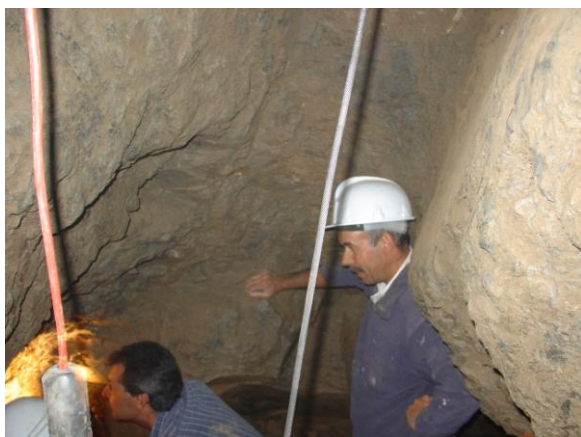
Foto 3 Momento da recolha de material para análise das paredes da galeria do poço do Bovinho
