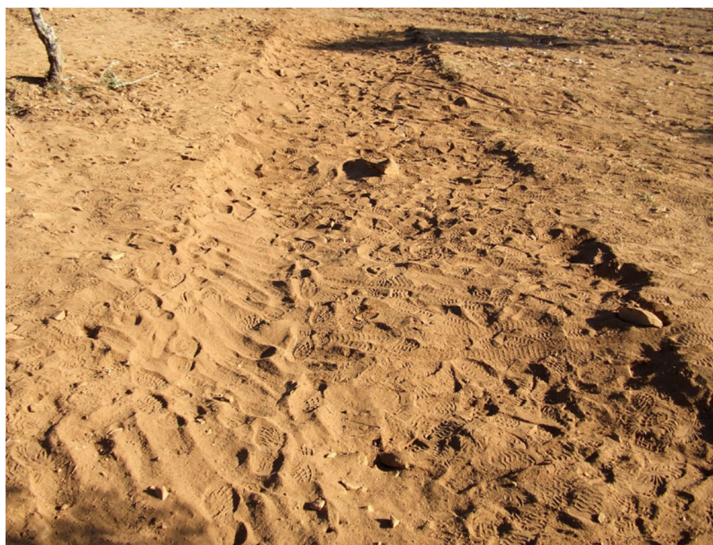
Fotografia 14 – A zona interven- cionada após preenchimento com geotêxtil e terra de crivo.
