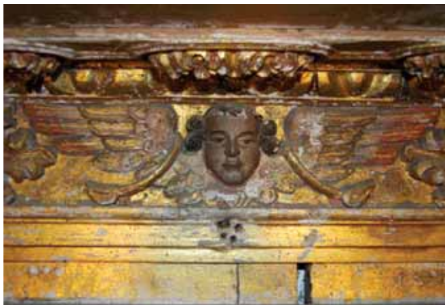
Fig. 109 — Face alada do entablamento antes da intervenção de conservação e restauro.
