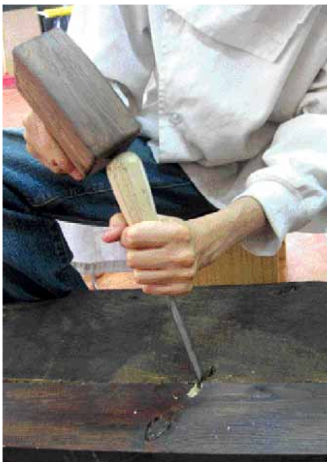
Fig. 72 — Abertura de caixas para introdução de peças de madeira para reforço das juntas.
