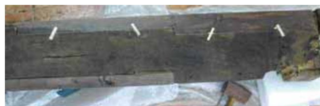
Fig. 74 — Vista do reverso do entablamento após a aplicação dos enxertos de madeira.
