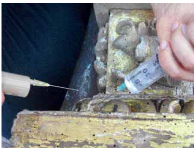
Fig. 35 — Pormenor do entablamento durante a fixação.
