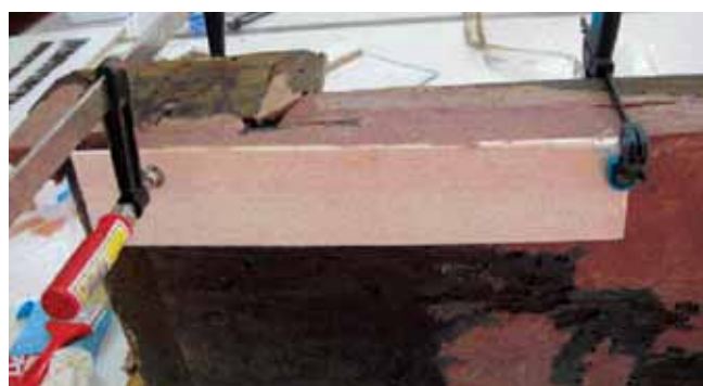
Fig. 53 — Pormenor do reverso do entablamento durante o preenchimento de lacunas com massa epóxida.
