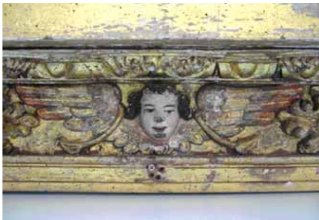
Fig. 110 — O mesmo pormenor após a limpeza química aturada a cotonete.
