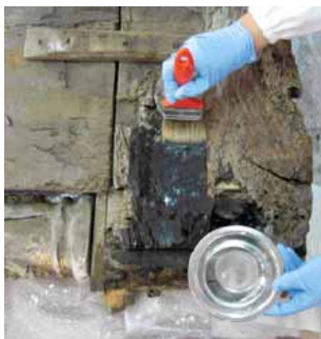
Fig. 32 — Pormenor durante a consolidação por pincelagem.
