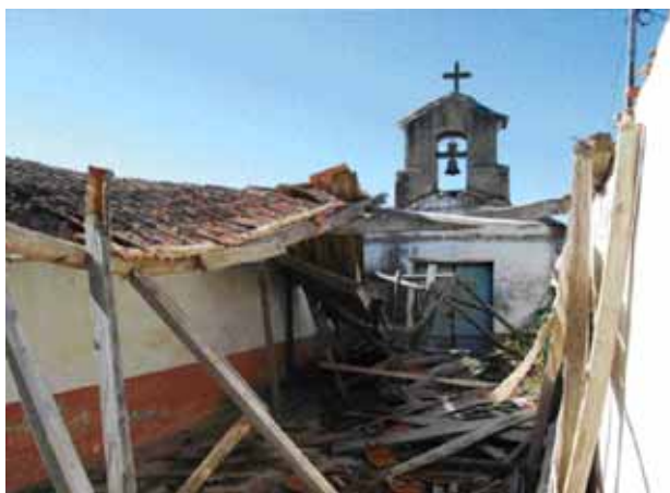
Fig. 5 — Interior da nave
