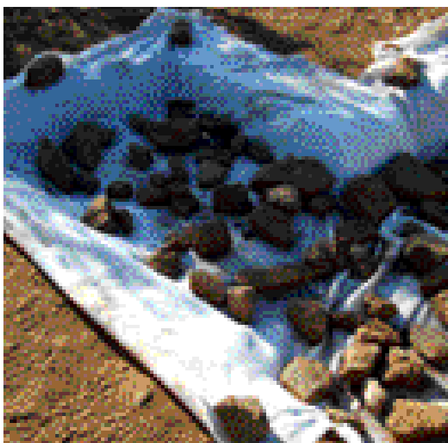
Fot. 10 – Situação após preenchimento da área intervencionada com geotêxtil e antes do enchimento com terra de crivo
