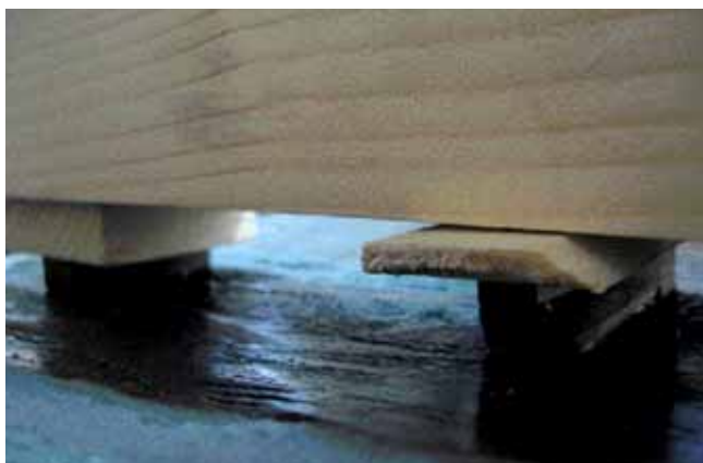
Fig. 67 — Pormenor durante a fixação da colagem das peças de madeira de reforço. Devido às irregularidades da superfície foi necessário, não só aplicar madeira de balsa na superfície de contacto, como utilizar calços para exercer pressão nas zonas mais baixas.
