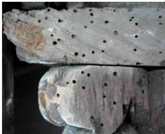
Fig. 8 — Pormenor de marcas de insecto xilófago de ciclo larvar no reverso do capitel de uma das colunas.
