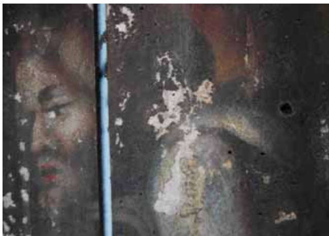
Fig. 128 — Pormenor em que é visível a separação das tábuas constituintes do painel, antes da intervenção.
