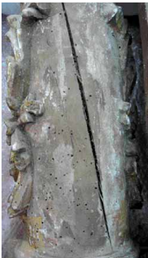
Fig. 16 — Pormenor do reverso da coluna direita, evidenciando fissura motivada por contracção do suporte.
