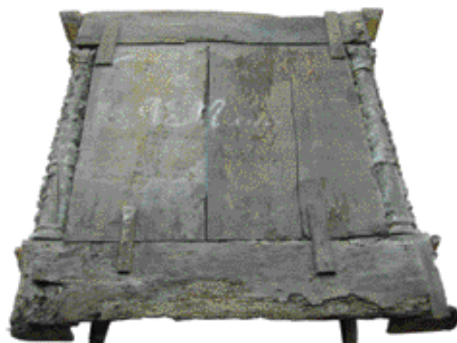
Fig. 2 — Vista geral do reverso antes da intervenção.
