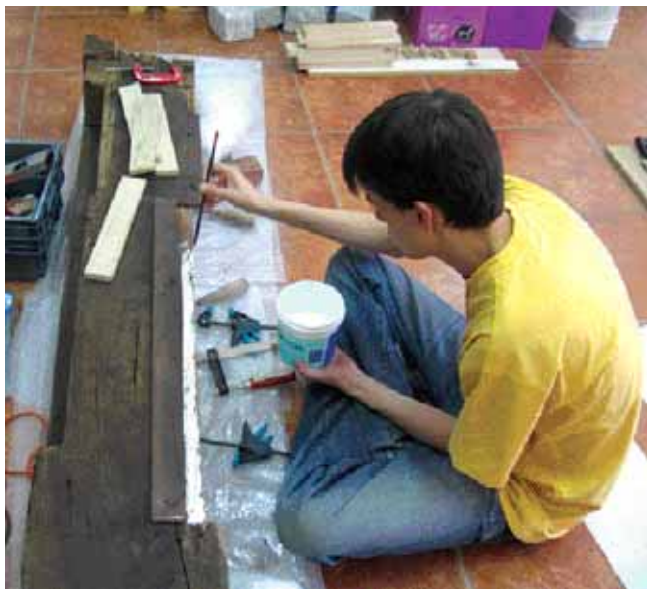
Fig. 70 — Aplicação de adesivo vinílico nas zonas de encaixe.
