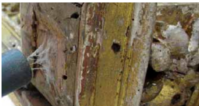
Fig. 38 — Pormenor da conclusão da limpeza mecânica do entablamento após a desmontagem.
