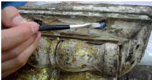
Fig. 37 — Pormenor durante a aplicação de conversor de óxidos sobre a cabeça de um dos cravos que não foram extraídos.
