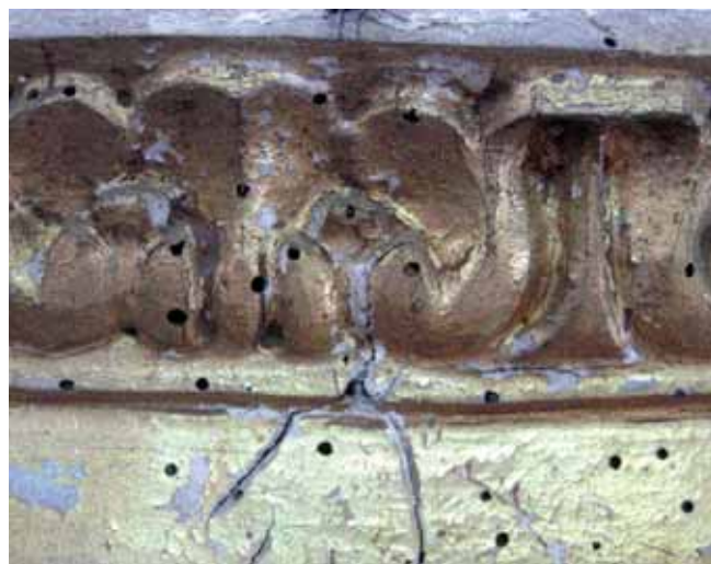
Fig. 7 — Pormenor de marcas de insecto xilófago de ciclo larvar na superfície dourada.
