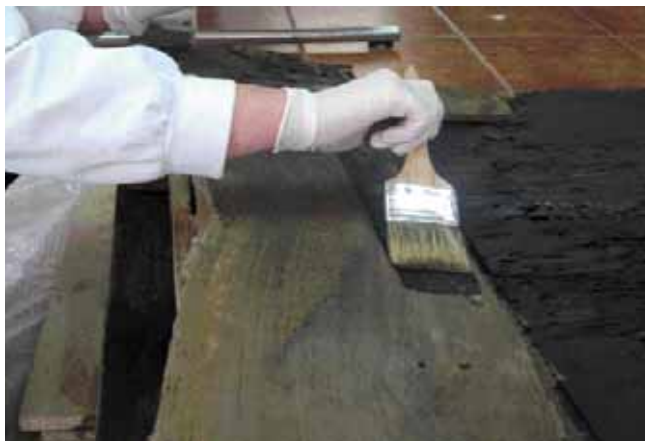
Fig. 33 — Pormenor durante a consolidação por pincelagem.
