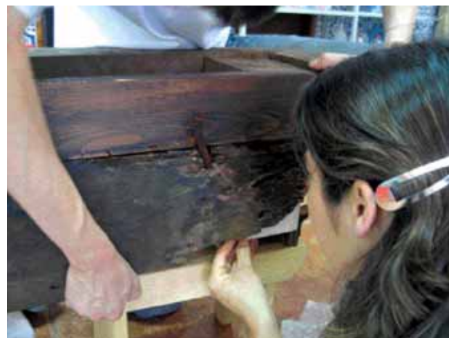
Fig. 75 — Pormenor durante a aplicação de uma peça de madeira para eliminação de espaço vazio entre dois dos elementos de constituição do suporte do entablamento.
