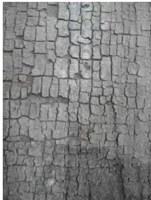
Fig. 14 — Pormenor do reverso da pintura, evidenciando o ataque de fungos.
