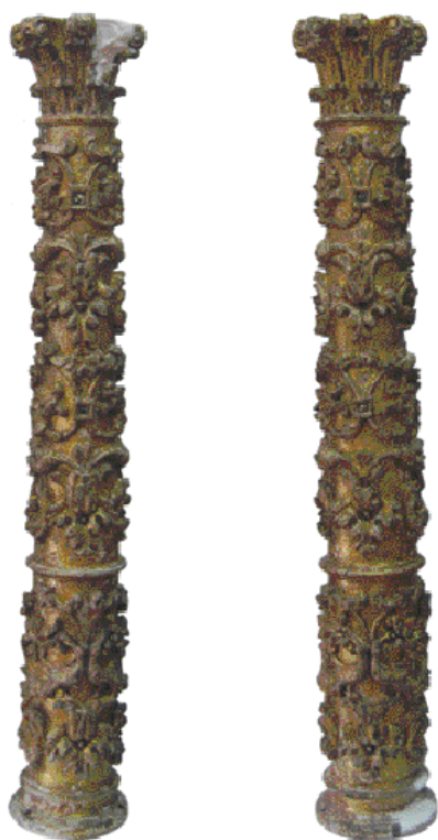
Imagens 113 e 114 — Colunas do retábulo após a aplicação de massas de preenchimento e colmatação de fendas e fissuras.
