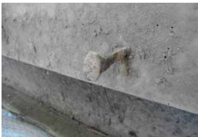
Fig. 21 — Pormenor do cravo metálico de grandes dimensões que foi aplicado no topo do entablamento para suspensão do conjunto na parede.
