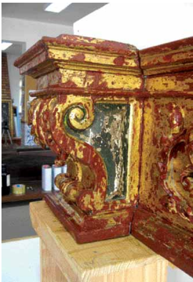
Fig. 101 — Terminada a aplicação de bolos nas lacunas a reintegrar com micas.
