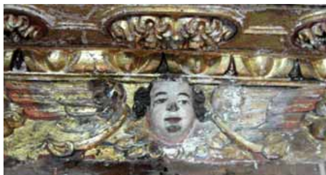
Fig. 47 — Pormenor do entablamento durante a aplicação do filme de protecção, evidenciado a saturação das cores na área já protegida, à esquerda.
