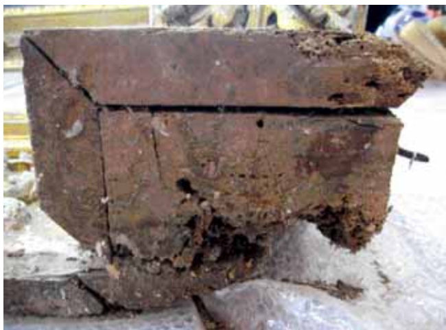
Fig. 12 — Pormenor da base de um dos plintos da predela, evidenciando o ataque de térmitas.
