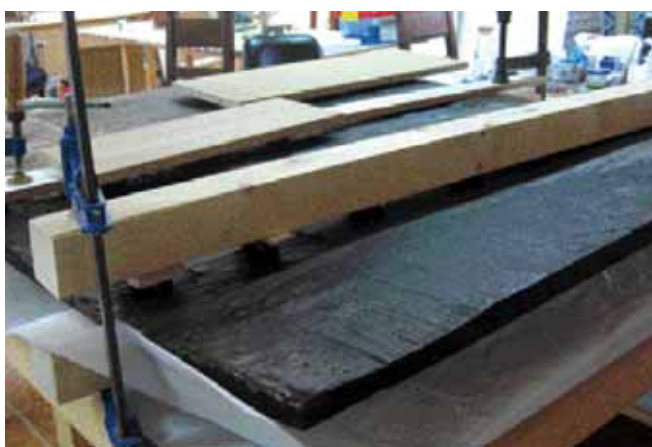
Fig. 66 — Fixação da colagem das peças de madeira através do uso de barrotes e grampos.
