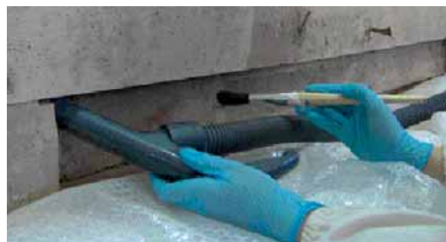
Fig. 28 — Pormenor durante a limpeza mecânica do reverso do entablamento.
