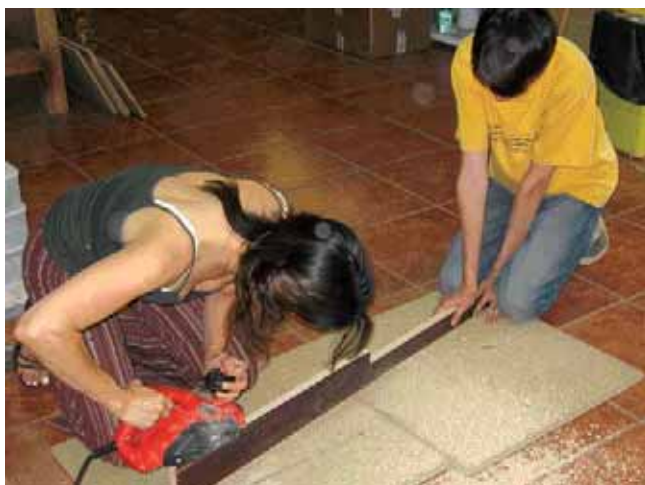
Fig. 69 — Preparação dos enxertos de madeira a aplicar no reverso do entablamento.
