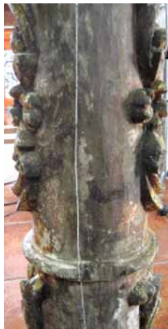
Fig. 56 — Pormenor do reverso de uma das colunas após o preenchimento das fissuras com madeira de balsa.
