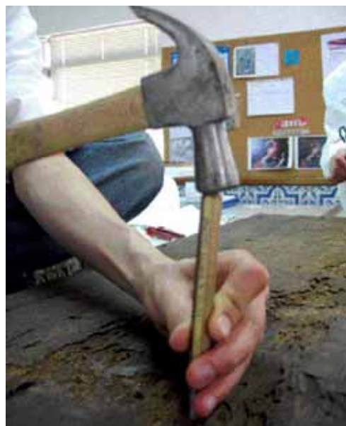
Fig. 63 — Pormenor durante a extracção de um dos cravos com punção e martelo.
