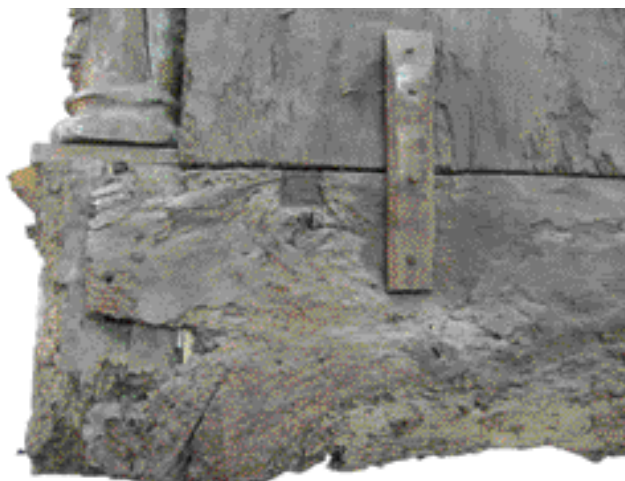
Fig. 3 — Pormenor do canto inferior direito visto pelo reverso. É visível uma das réguas de madeira que uniam o painel à estrutura do retábulo.
