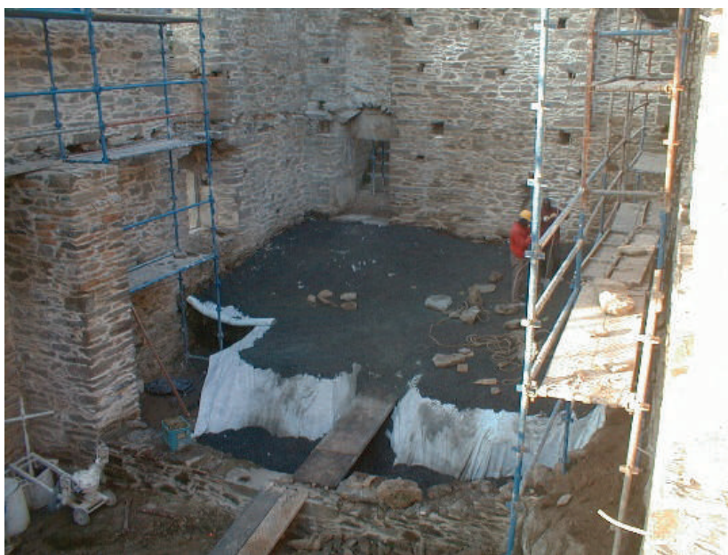
Aspecto da intervenção no Real Filatório
