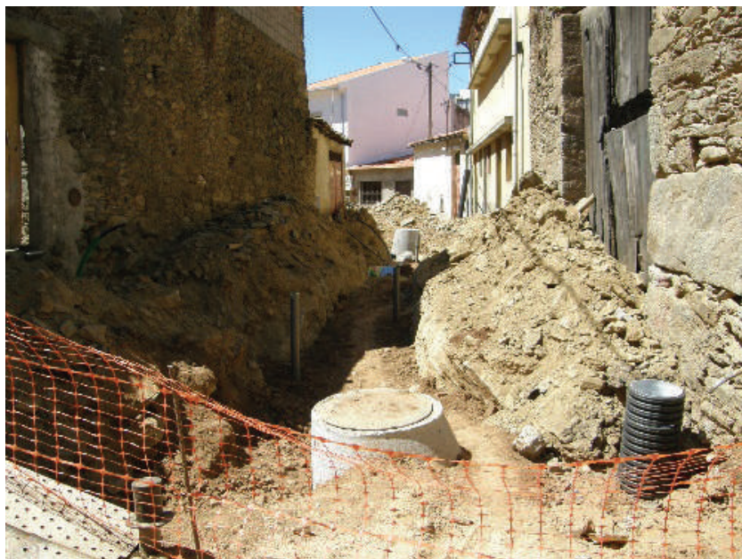
Aspecto das obras de saneamento básico em Prado de Cavaleiros
