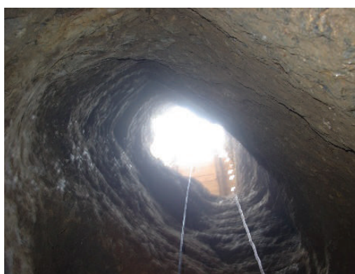
Aspecto de baixo para cima do poço de vento
