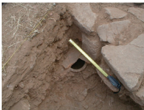
Vaso tapado com telha nas suas fundações
