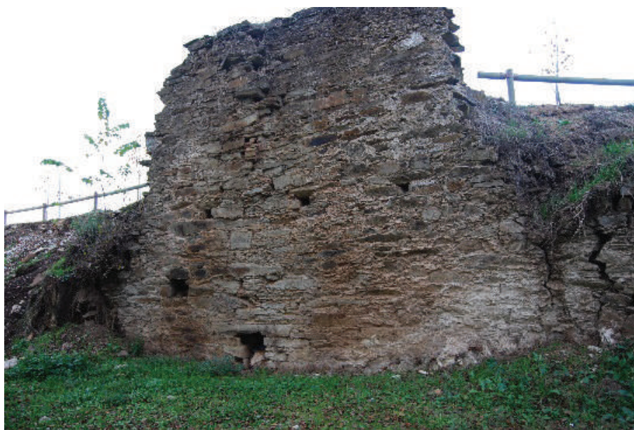
Forno de 1.ª geração de cal de Vale da Porca
