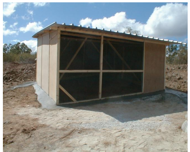
(Cobertura provisória do forno)
