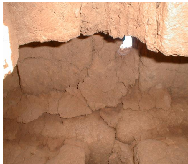
(Tecto do forno, avistando-se um dos orifícios de saída da chama)
