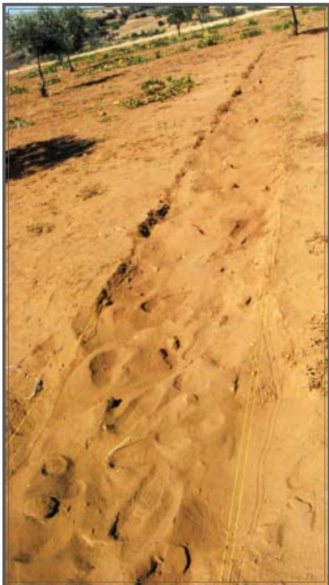
Fot. 13 - A área intervencionada (NE-SO) após a colocação do Geotêxtil e da terra de crivo.
