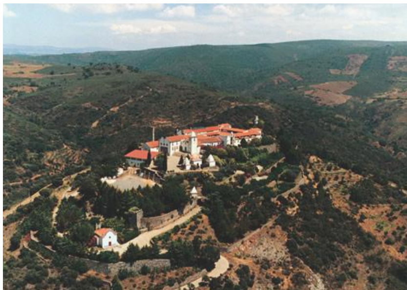
Fig.2 Vista Aérea do Convento de Balsamão. Foto: Site oficial dos Marianos da Imaculada Conceição.
