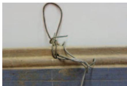
IMAGEM 1 - ELEMENTO DE SUSTENTAÇÃO INADEQUADO.
